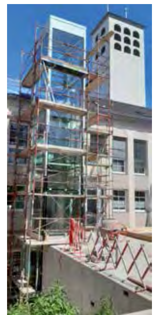
2022 Lifteinbau für den barrierefreien Zugang zu allen Stockwerken
