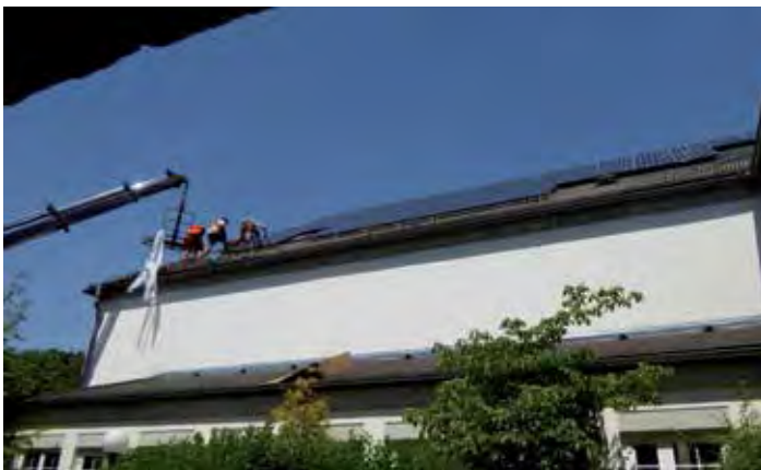
2017 Einbau einer Photovoltaikanlage
